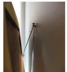
*Pour obtenir un système sécurisé faites passer le câble dans un piton à oeil ou un stopper vissés dans le mur : le décrochage sans outil devient impossible*
